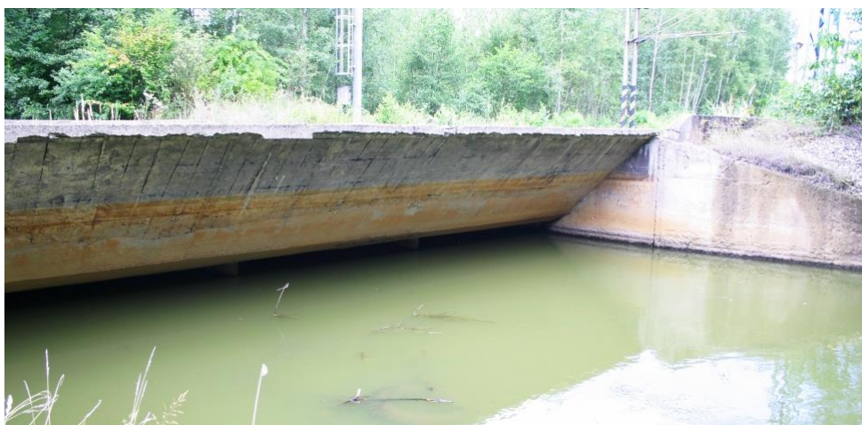
Obr 10: Mírně rizikové místo: železniční most u Komořan Fig 10: Railroad bridge downstream of Komořany village assessed as potentially dangerous.
